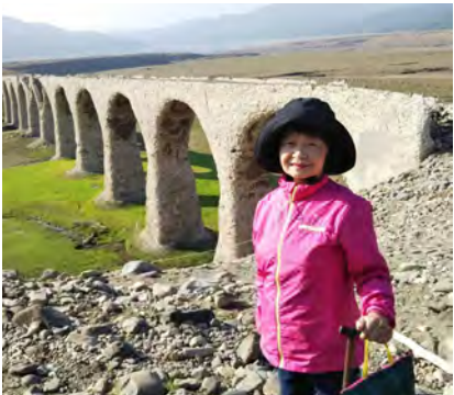
「旧国鉄士幌線タウシユベツ川橋梁」
