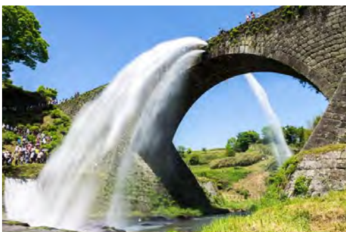
熊本市内バスターミナルからバスで1時間半。黄金色の田んぼの中に通潤橋がそびえていた。「通潤橋」嘉永7年(1854)に架けられた石造単アーチ橋。橋長78m、幅6.3m、高さ20m。週末の1日に15分しか放水しないというので、それまで石橋の上を歩きながらその時を待つ。時間となり、橋中央から両側に放水が始まった。用水管内の泥砂利を除く
