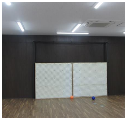
教壇を立ち上げるとハンドボールのゴールポストになる ネットの代わりに反発系ウレタン
