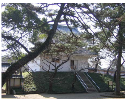
平成10年に復元された東櫓、素晴らしい木造32坪、建築費は1億8千万といわれ、市立博物館付属展示館となっている
